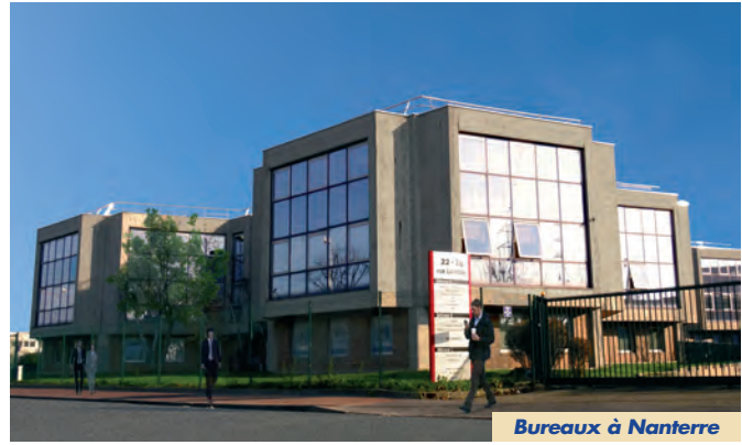
Bureaux à Nanterre
